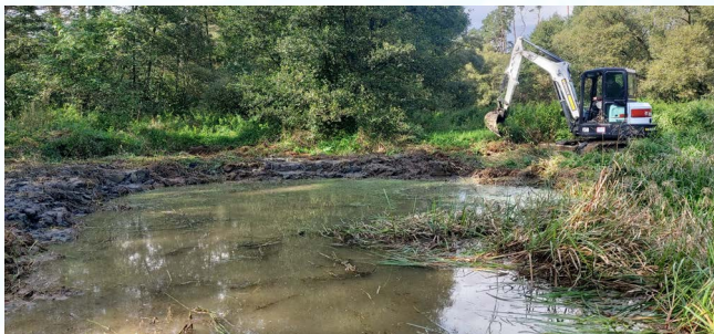
Obnova tůně těžkou technikou, část porostu vegetace zůstane na svém místě.
